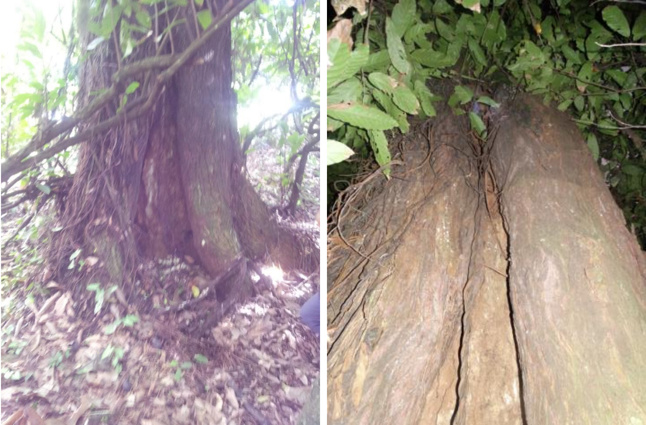
Fotos 5-20 e 5-21: Cavidade na base do tronco.
