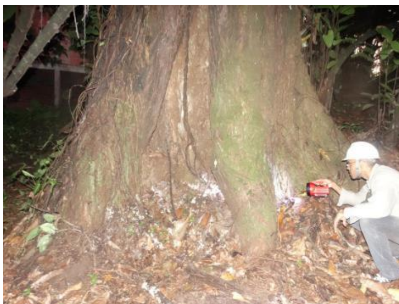
Foto 5-25- Grande rachadura na base, estendendo-se ao sistema radicular. Na porção Nordeste do colo observa-se leve erosão laminar expondo parcialmente a raiz.
