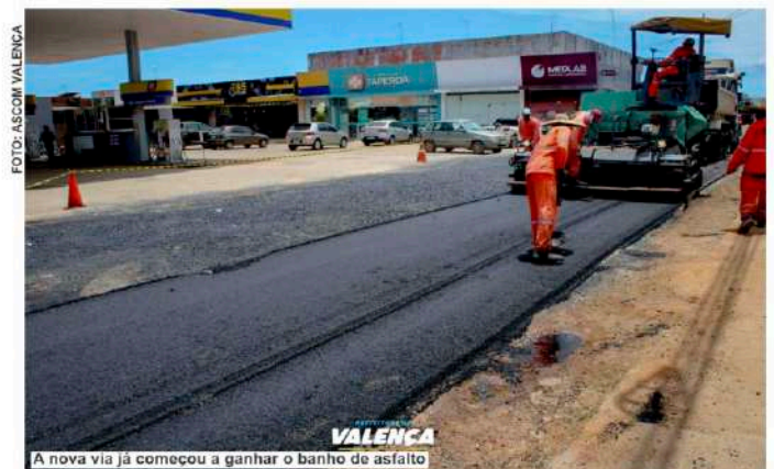
A nova via já começou a ganhar o banho de asfalto
