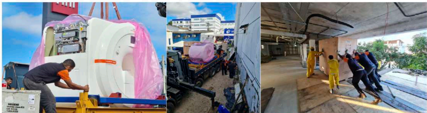
Registros da chegada dos equipamentos na sede da Uniclín Pró-Saúde
