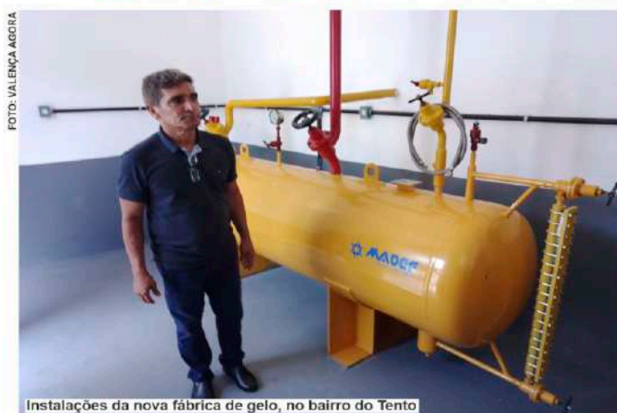
Instalações da nova fábrica de gelo, no bairro do Tento
