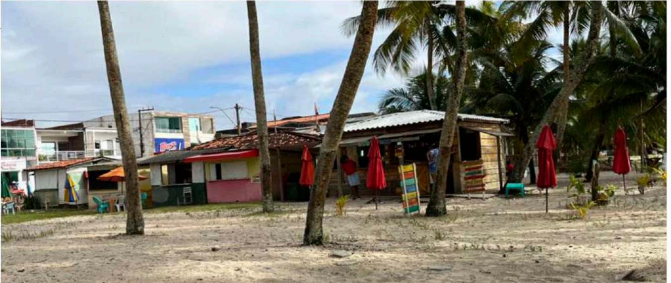
O MPF destaca a existência de edificações estilo barracas de praia, restaurantes e residências com estruturas fixas e irregularmente construídas na praia de Guaibim, além de barracas/containers, boutiques, lanchonetes, barraca de sorvete, e algumas barracas improvisadas e precárias na Praia de Taquari.
