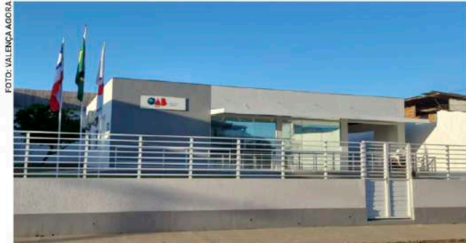
Sede da OAB subseção Valença está localizada no bairro do Novo Horizonte
