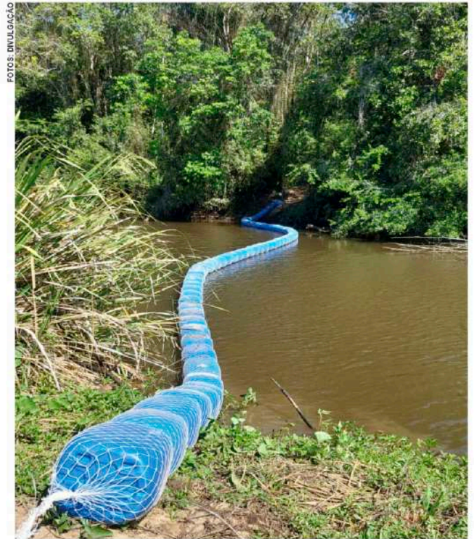
As ecobarreiras são estruturas flutuantes instaladas transversalmente em rios, córregos e canais que bloqueiam o escoamento dos resíduos sólidos flutuantes
