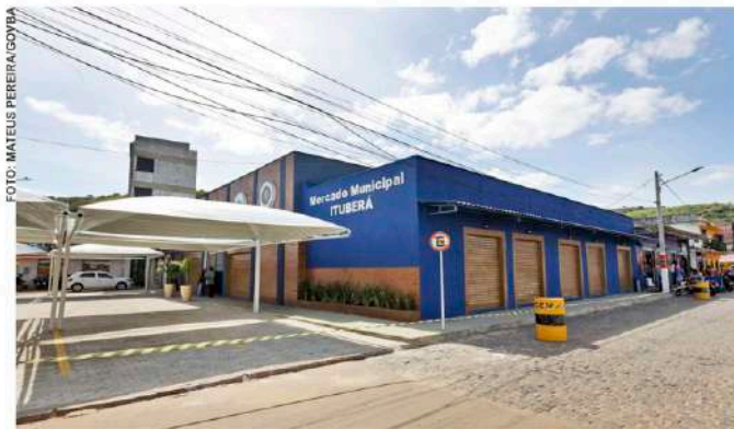
Ituberá recebeu ainda um novo mercado municipal, após reforma do antigo espaço
