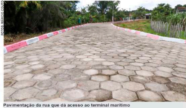
Pavimentação da rua que dá acesso ao terminal marítimo
