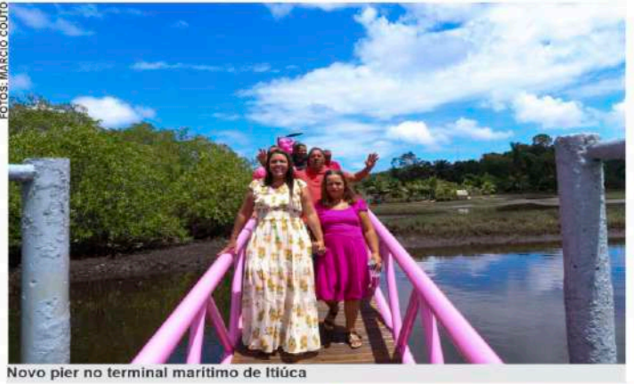
Novo pier no terminal marítimo de Itiúca
