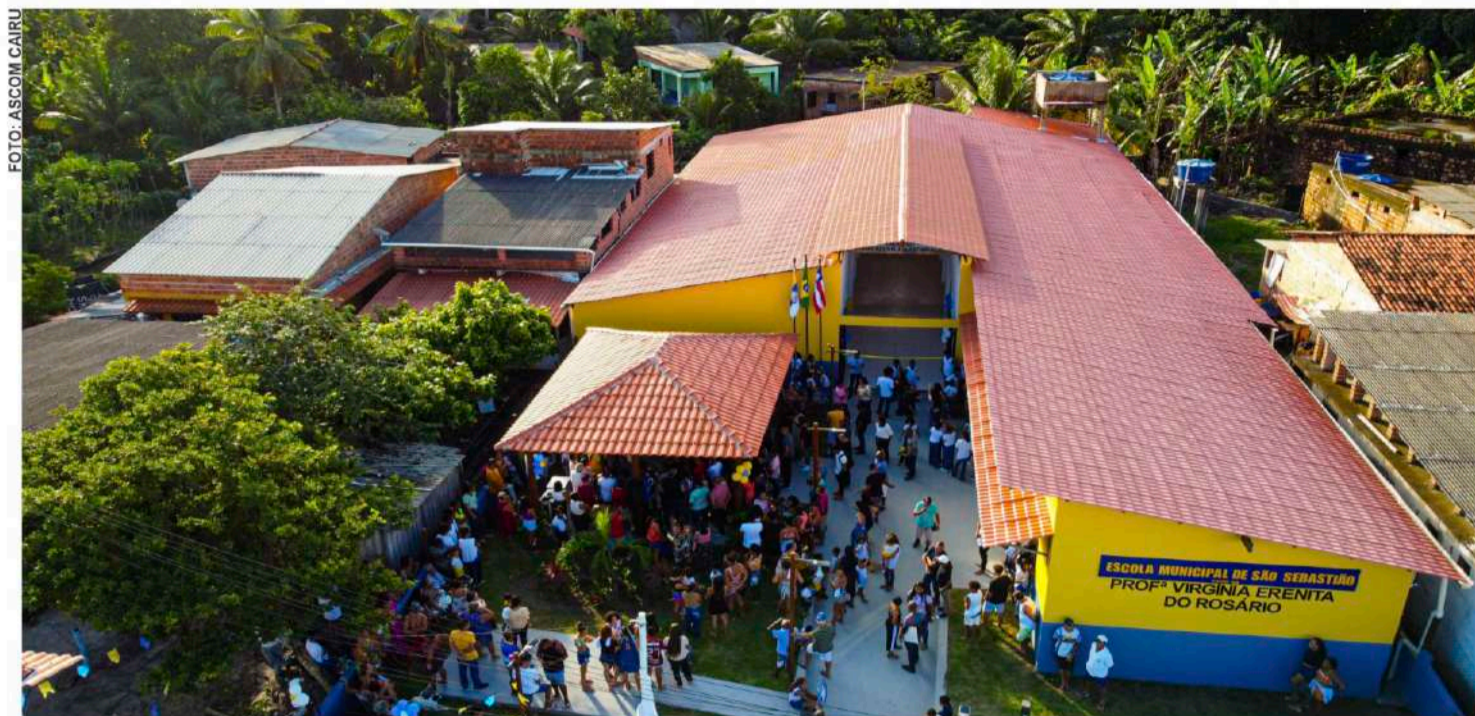
O prédio escolar foi reconstruído com recursos próprios, tendo a base estrutural existente ganhado uma moderna leitura espacial.
