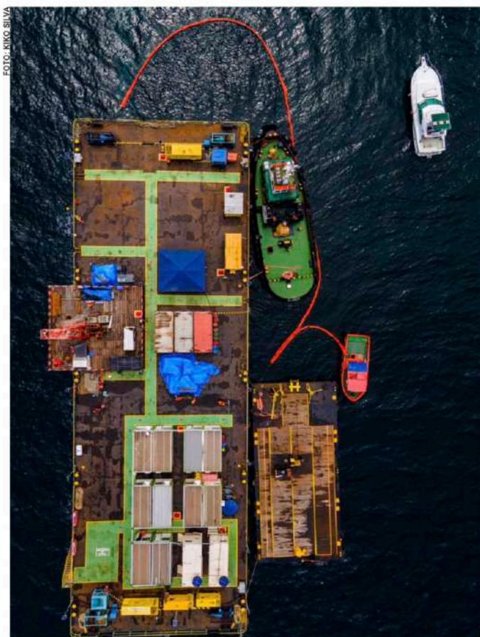
Em cima da balsa que atua em águas profundas foram instalados também 15 contêineres. Eles passam a funcionar como uma espécie de canteiro de obras avançado ao mar, com equipes de operação, suporte técnico, administrativo e almoxarifado.
