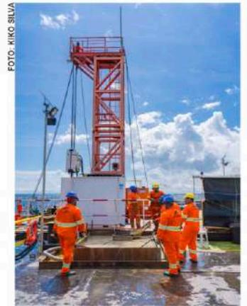
Montado sobre a balsa está um equipamento de perfuração que veio da China exclusivamente para execução da sondagem da ponte e que marca o início do intercâmbio tecnológico Brasil-China proporcionado através desse projeto.
