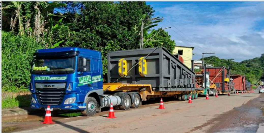
Novos equipamentos começaram a chegar no dia 3 de julho, transportados por caminhões especiais
