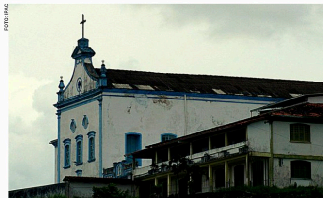
A obra, orçada em R$ 2.138.525,40 visa a recuperação estrutural da cobertura da igreja
